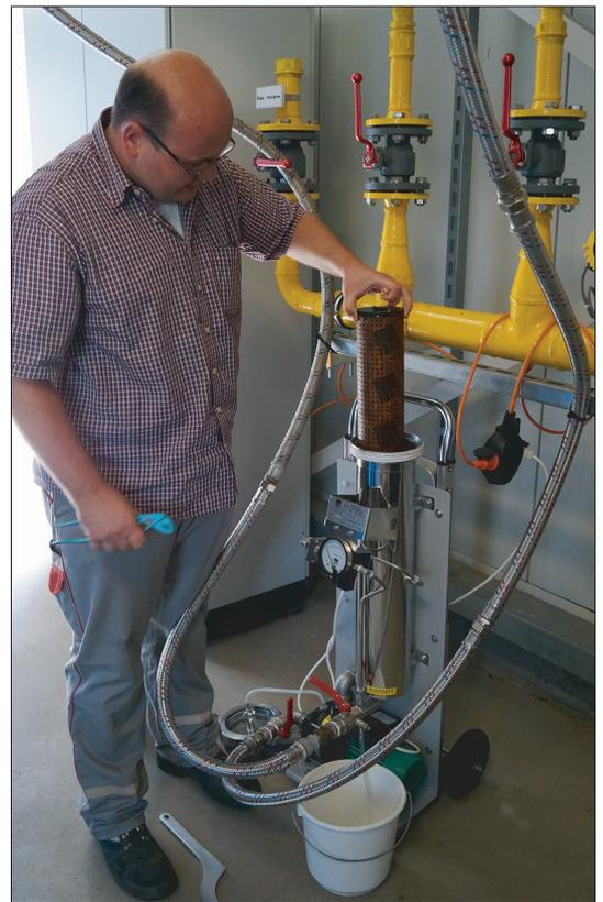
*Bild 3. Filterwechsel in zwei Minuten: Wasser ablassen, Deckel aufschrauben, alten Filter herausholen, neuen Filter einsetzen, Deckel wieder zuschrauben* Quelle: Angster
