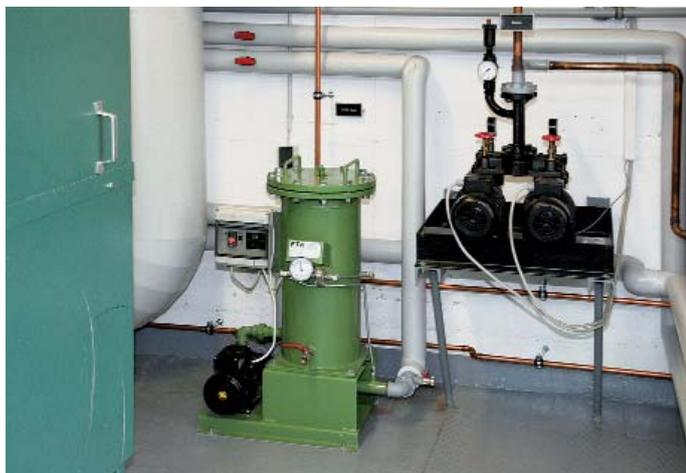
Seit die stationär in der Botnanger Heizzentrale installierte FTK-FF 4-6P Filteranlage mit 6,8 m<sup>2</sup> Filterfläche von Kausch in Betrieb ist, hat sich der Anlagenzustand erheblich verbessert.
